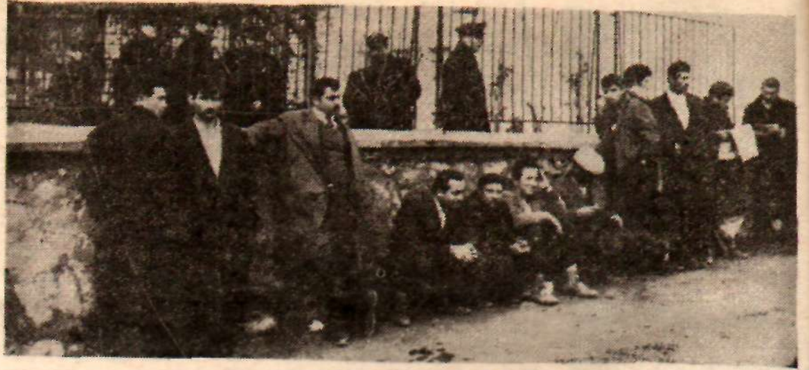
Kavel Kablo Fabrikası önünde işçilerin kurduğu «Grev hattı»
